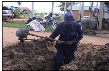
សកម្មភាពតភ្ជាប់បណ្តាញផ្ទះ House connection installation
