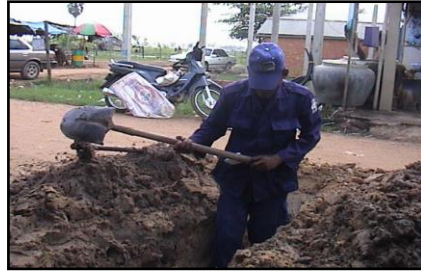
សកម្មភាពតភ្ជាប់បណ្តាញចូលផ្ទះ House connection installation
